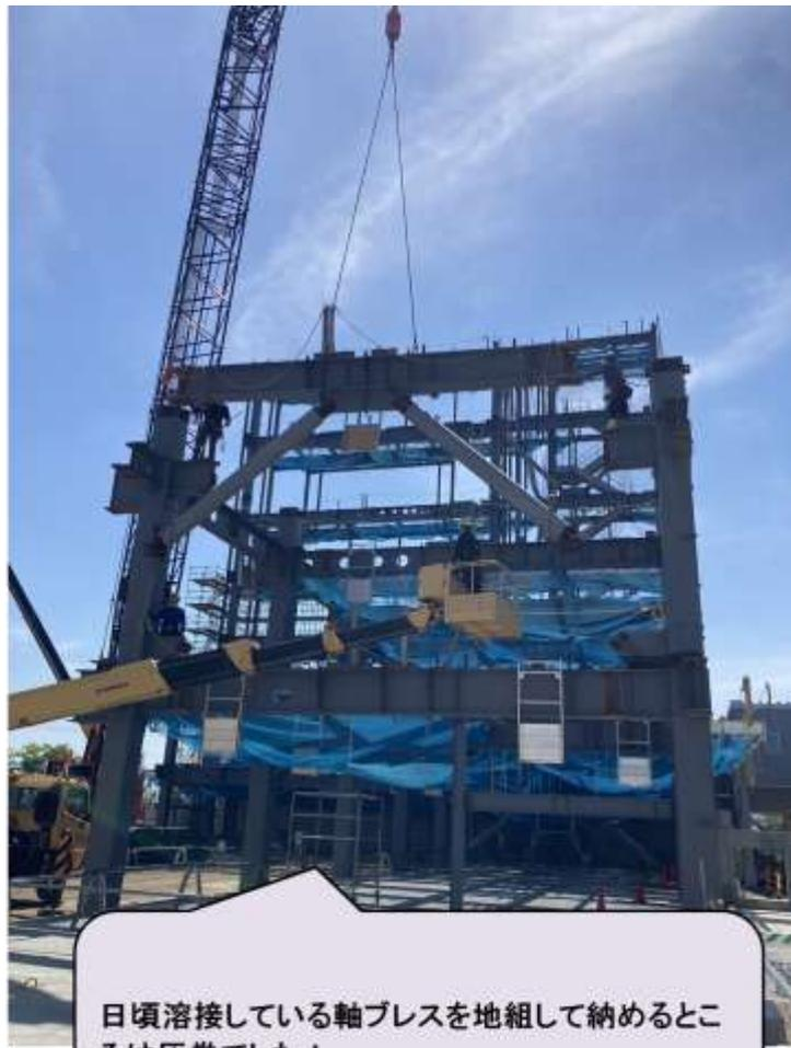
日頃溶接している軸プレスを地組して納めるところは圧巻でした！
