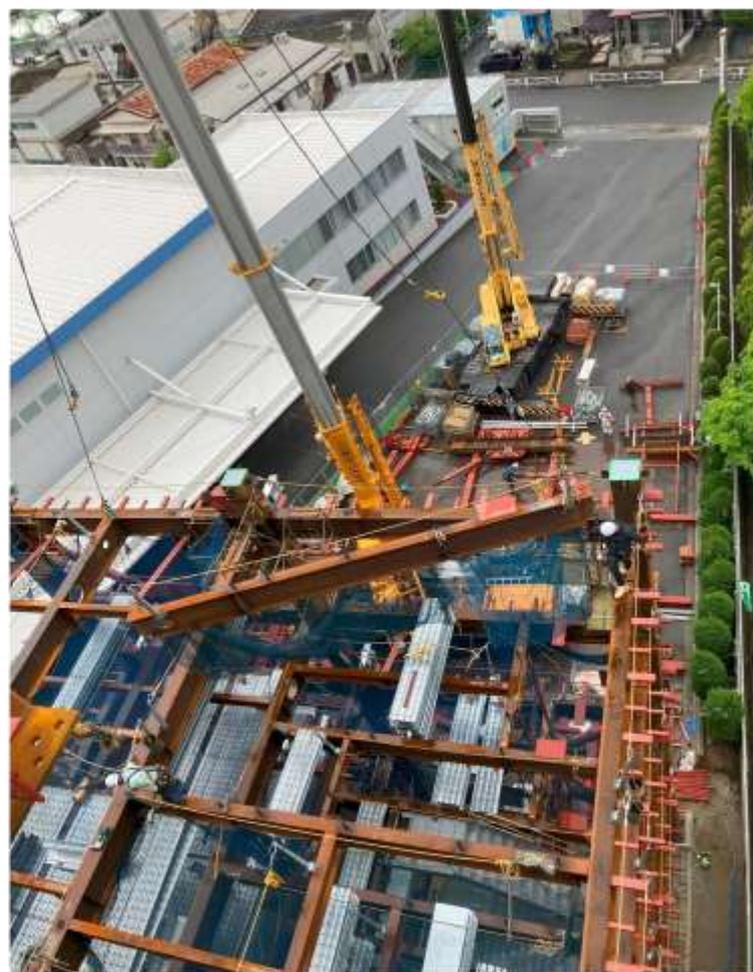
建てないと次のトラックの荷降ろしもできないような狭いヤードの中で材料の置き方を工夫したりデッキを先行搬入から当日搬入へ変更などして非常に苦労しました。
